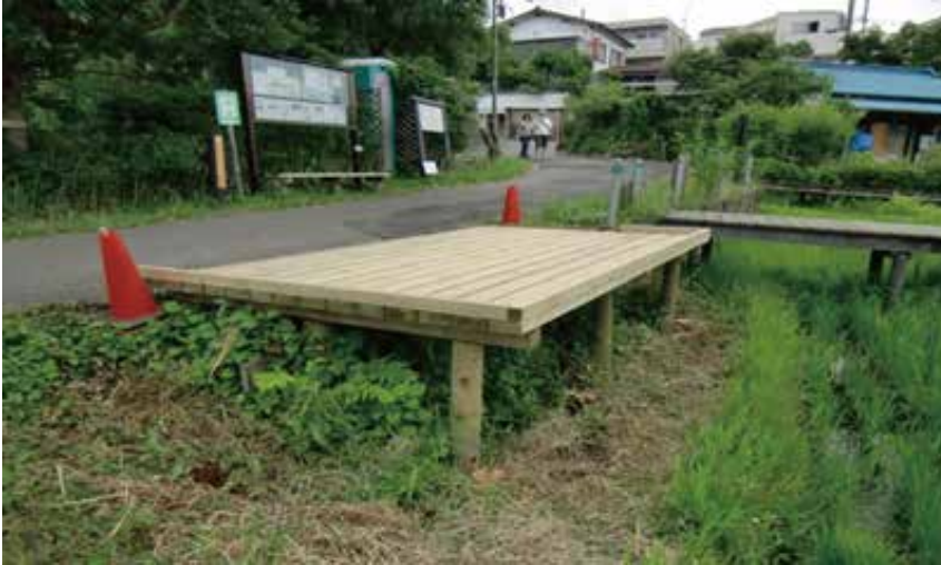
更新した「見学デッキ」と奥のベンチ
