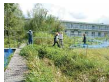
田んぼ東側のパイプ組み立て
