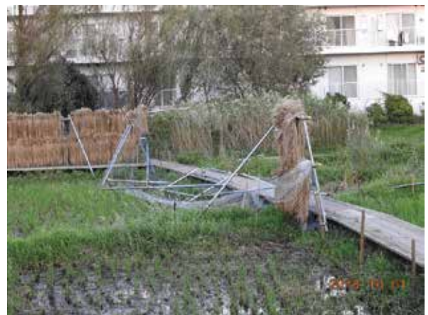
中央木道沿いが台風で倒壊しました
