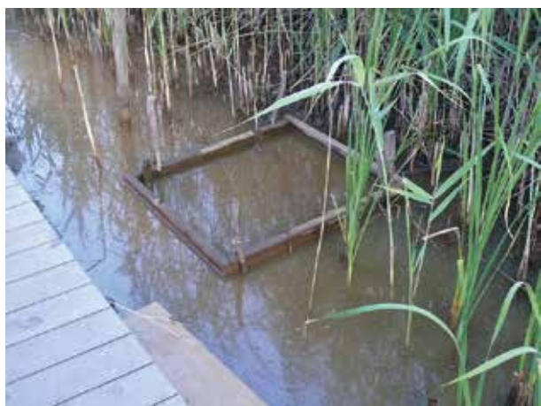
木枠をつくり、深場を作りました
