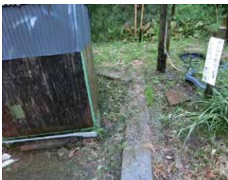
小屋の周辺の雑草処理した後
