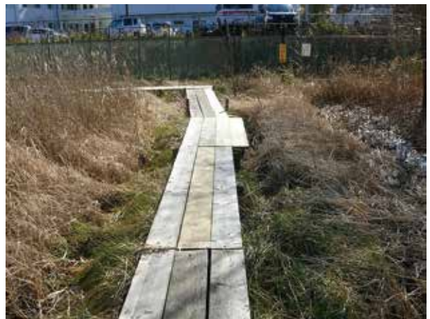
回生の里側（修繕後）
