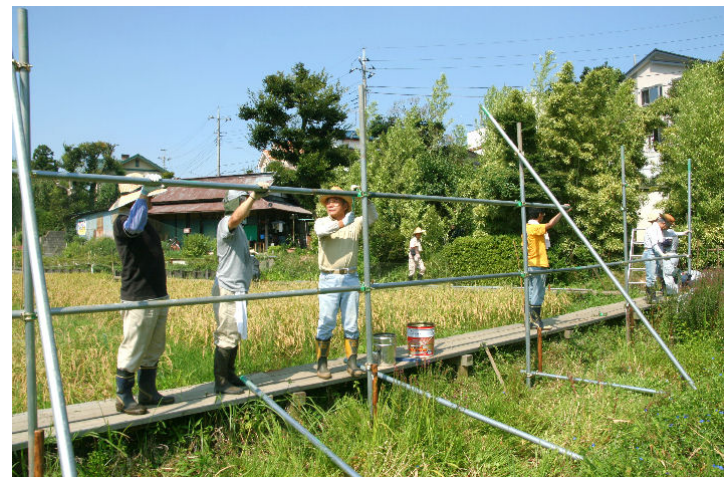
パイプをジョイントでつないで組み立てる
