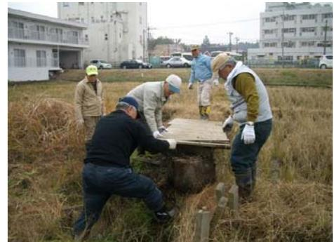
不耕起部会最後の仕事は12月10日(月)に9名の会員で行った深田の土量不足を補うための水田周囲の水路浚渫でした。水路を跨いでの作業は結構「キツイ」作業でした。また、漏水対策として議論した結果、水路周囲の畦の内側をぶらの波板で補強することになり、2月から作業にとりかかることに決まりました。
