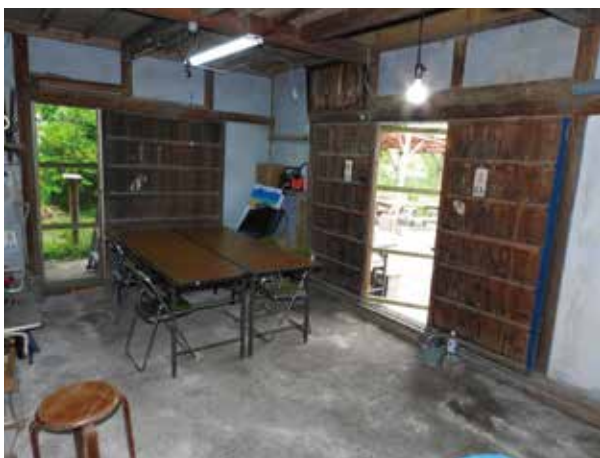
照明点灯時の倉庫内部の状況
