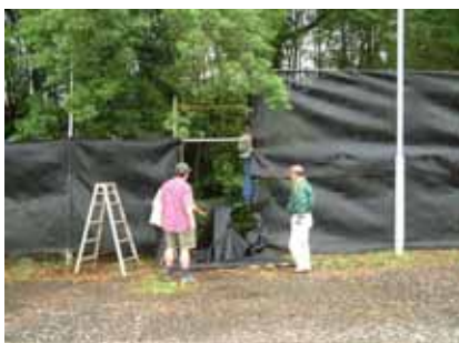
D2横の遮光ネット張り
