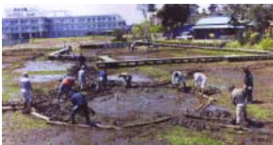
4月6日 水路・水温調整池づくり
