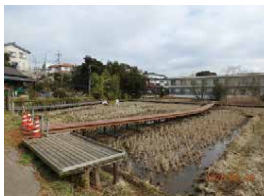
Aゾーン中央木道が市の工事で更新されました
