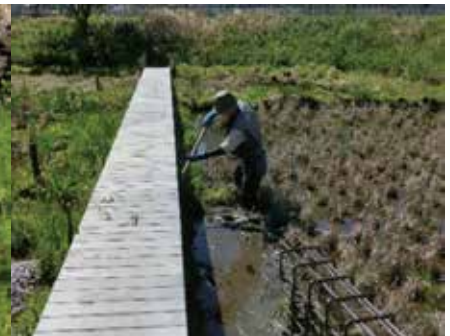
畦の修復作業風景
