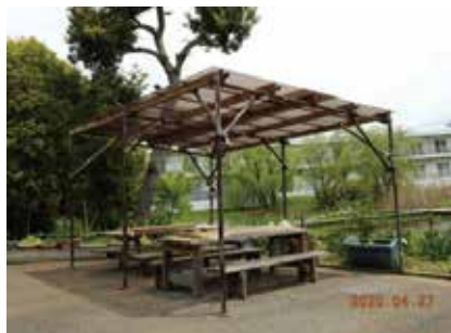
作業小屋前の休憩陽除けベンチ上に屋根をかけました。（4、5月の幹事会はここで開催）
