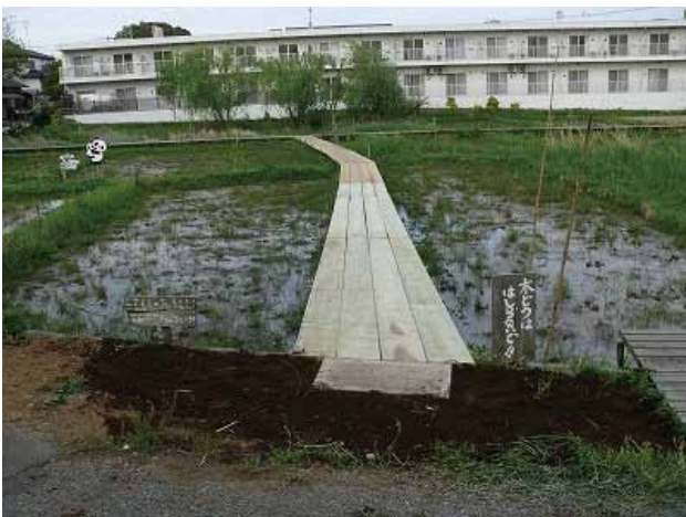
Aゾーン中央木道の改修完了
